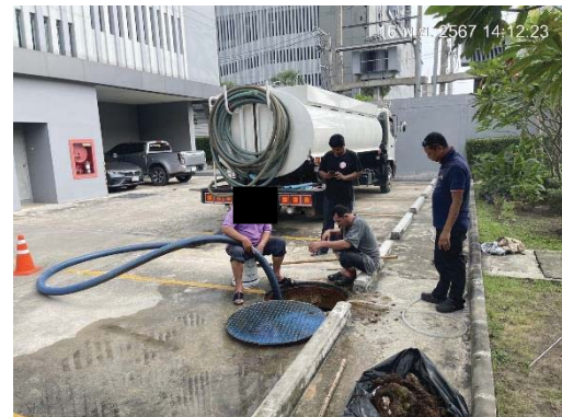
สูบน้ำตะกอนส่วนเกินจากระบบบำบัดน้ำเสีย
